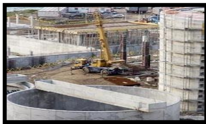
Foto No 1: Obras de la Estación Depuradora de Aguas Residuales
