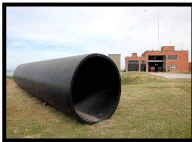
Foto No 1: Tubería para el emsuario submarino en Mar del Plata.
