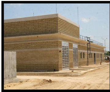
Foto No 2: Planta de Tratamiento del Emisario Submarino en el Distrito de Cartagena de Indias.
