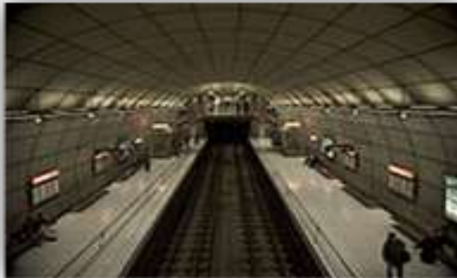
Foto 11. Interior de la estación de San Mamés en el Metro de Bilbao.
